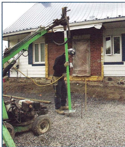
Les pieux vissés en acier structural galvanisé à chaud de Techno Pieux sont recouverts d'une gaine résistante en polyéthylène de façon à mieux les protéger contre les mouvements de sol causés par le cycle de gel et dégel et le cycle de gonflement et d'affaissement de l'argile, ce qui leur donne une durée de vie de 40 ans une fois en terre.
