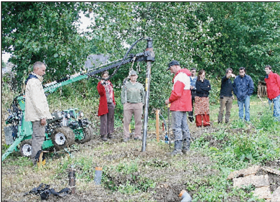
■ Démonstration de pose d'un pieu P3, d'un poids de 25 kg.
